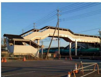
↑倉賀野駅の自由通路 途中に大きな段差があり、 バリアフリー化を困難に している
